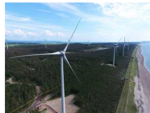
風の松原風力発電所(能代市)
